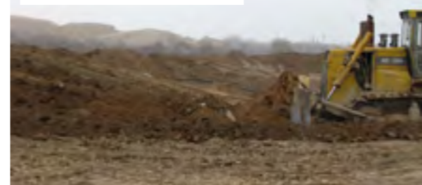
احداث سد بش قارداش
